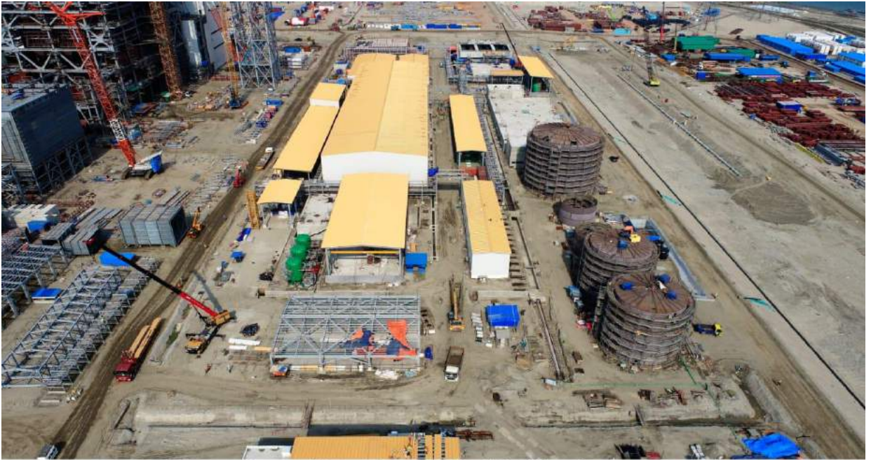
বিদ্যুৎ কেন্দ্রের Water Treatment Facilities নির্মাণ কার্যক্রম
