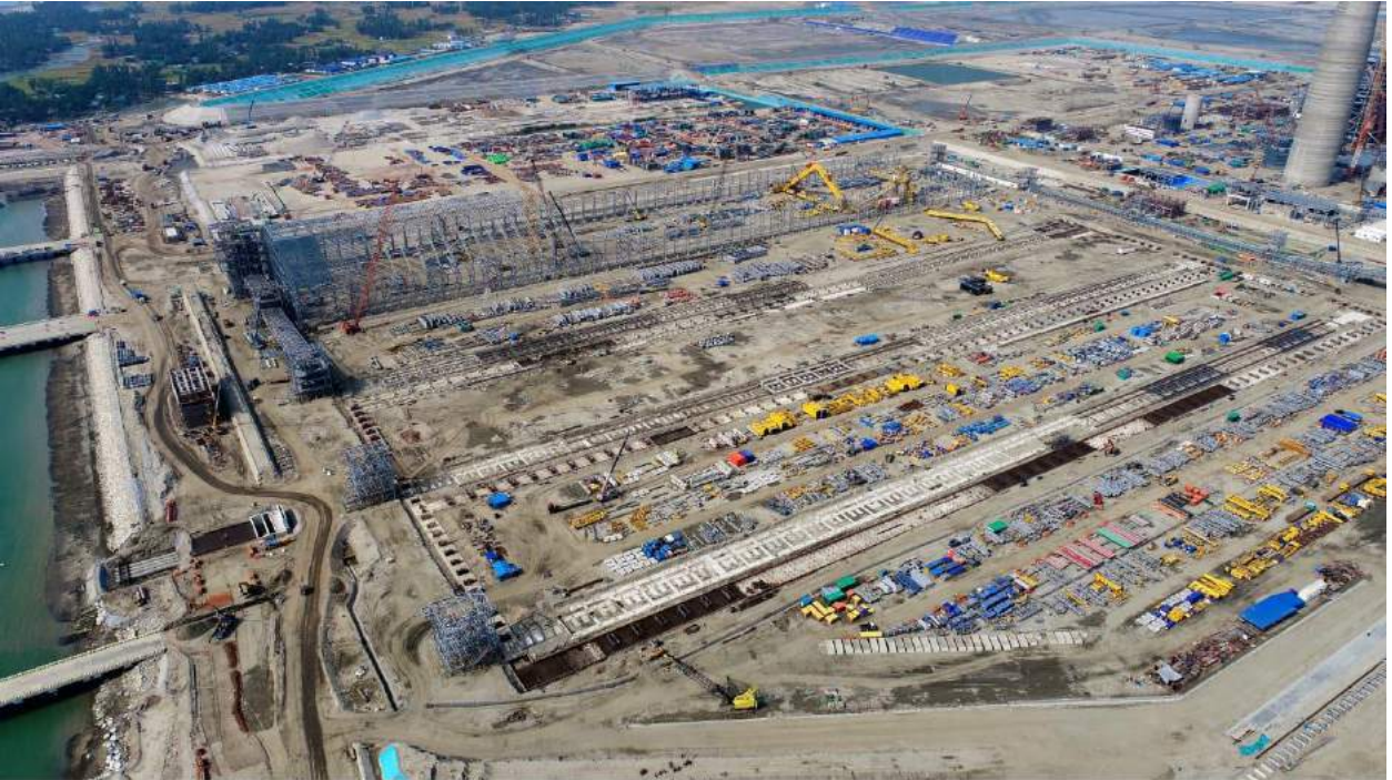
বিদ্যুৎ কেন্দ্রের কোলইয়ার্ড নির্মাণ কার্যক্রম
