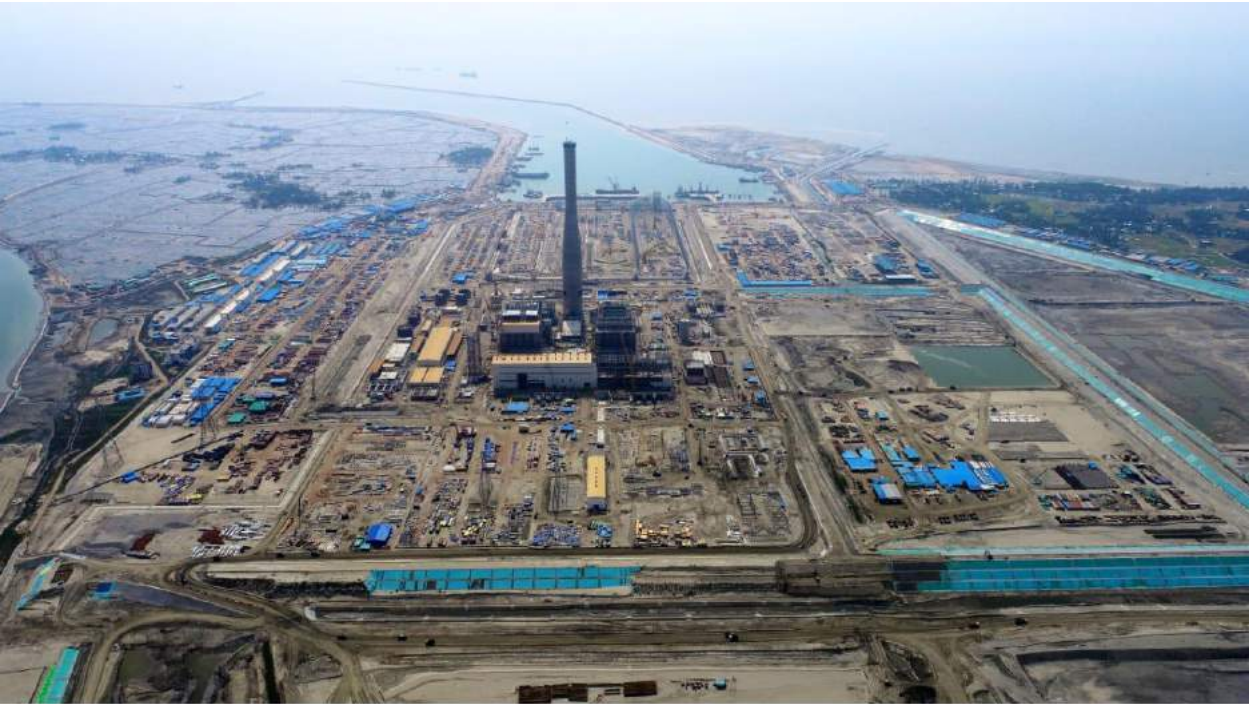
বিদ্যুৎ কেন্দ্রের নির্মাণ কার্যক্রম ও নির্মিত ২৭৫ মিটার উচ্চ চিমনি
