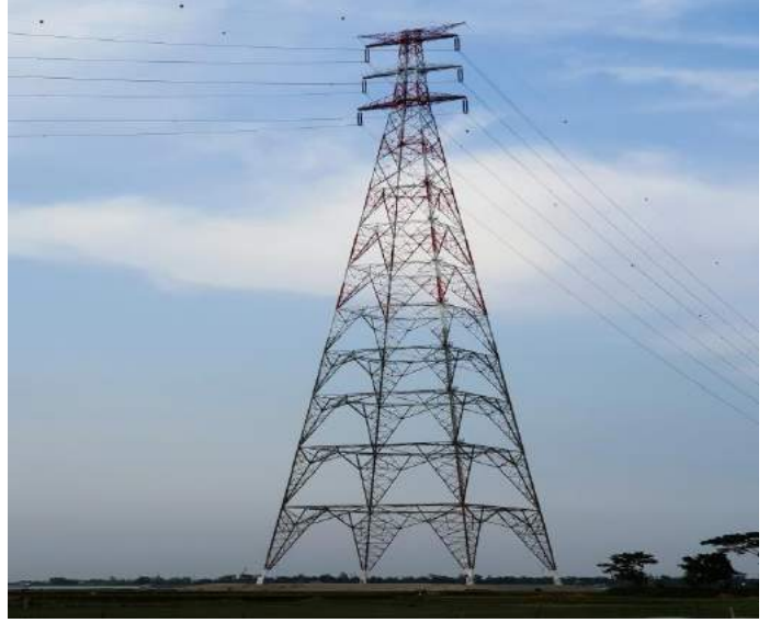
চিত্রঃ ৬১০ ফুট উঁচু রিভার ক্রসিং টাওয়ার, আশুগঞ্জ, রাম্ভাণবাড়িয়া।
